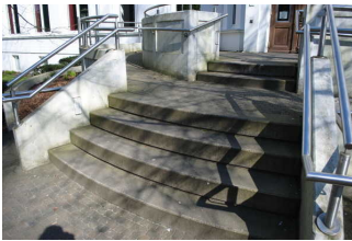
Treppe zum Eingang Altes Kurhaus
