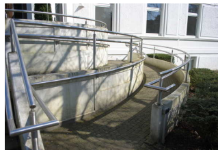
Rampe zum Eingang Altes Kurhaus
