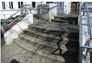
Treppe zum Eingang Altes Kurhaus
