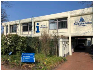
Außenansicht Tourist-Information Bad Zwischenahn
