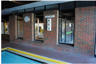
Tiefenanzeige des Hubboden im Therapiebecken
